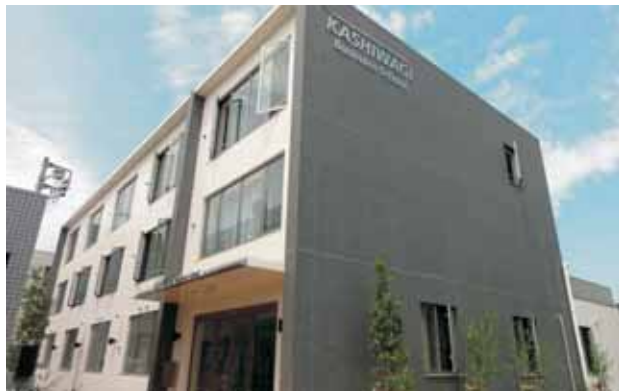
研修センター 完成 柏木実業専門学校
